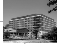
高槻病院 (ICU・PICU・SCU/ MFICU・NICU・GCU) 全477床
